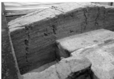
図111 石室に沿って版築層を突き破る地割れ（東西壁・南北から）
