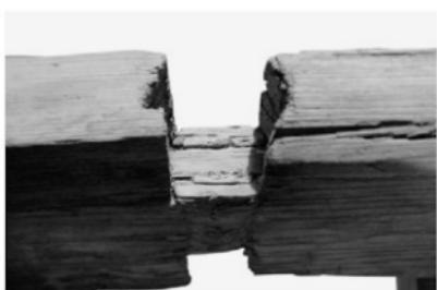
図15 相欠き仕口に打ち込まれた割り模 (西面南壁板2段目)
