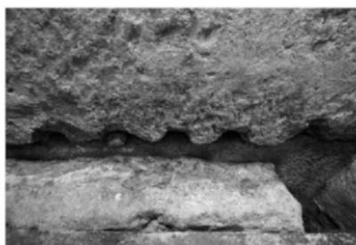
図100 南壁石南面下端の栓子穴
