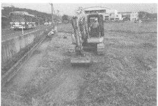
3. 1・2区 表土掘削状況
