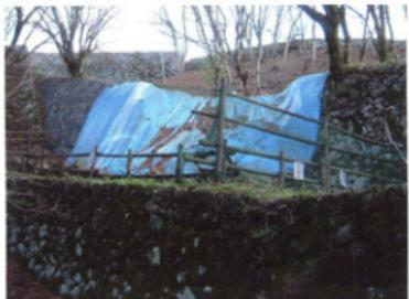
平成9年の山口県北部地震とその後の豪雨で石垣が崩落した箇所
