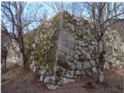
④大守台西及び南側の石垣。西側（左手）は慶長・元和の右垣と推定。南側（手前）の石垣は、焼け石が混じり、大火により天守が消失した直後（17世紀の終わり）の積み直しと推定（隅角部は算木積み）
