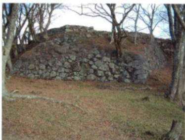
③慶长期の築造と推定される天守台東側の石垣。隅角部の角石の控えは長く、築石の控えもひとくわ長い
