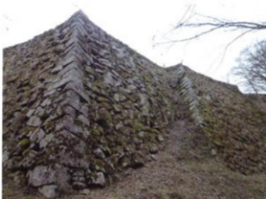
⑤慶長・元和の築造と推定される太鼓櫓の石垣。反り状を程し、津和野城跡の石垣の中では最も高い（約14m）
