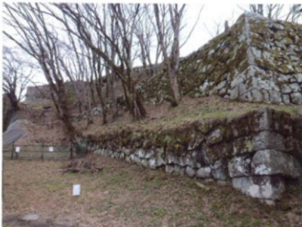
②慶長・元和の築造と推定される天守台北側及び腰曲輪の石垣。天守台や三十間台につながる象徴的大手道の景観を構成。左手中央は石垣が崩落（通行止め）
