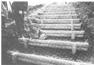
圓路階段工事
