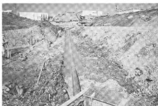
排水管埋設工事
