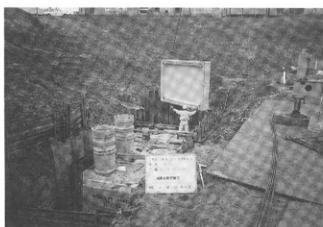
ポンピット工事
