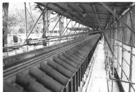
中～太鼓櫓間堀 屋根本瓦葺完了
