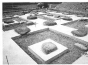
基礎石据付、コンクリート基礎の打設完了
