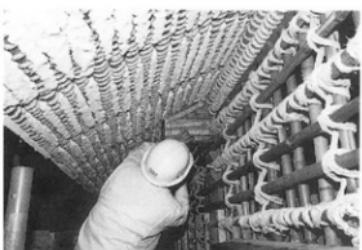
染の鼻先は縄巻きした割竹を打ち付けて下地とした
