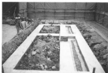
太鼓櫓の基礎コンクリート打設完了
