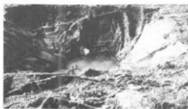
第15図 地下水面に至る(重機による試掘)
