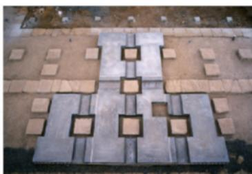
構造補強用コンクリートスラブ施工完了
