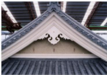
破風他砂漆喰塗り完了
