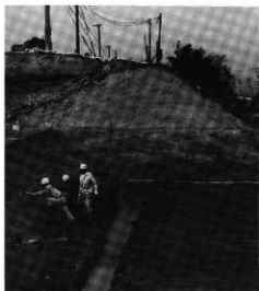
第4図 A区北側(南から北を望む)
