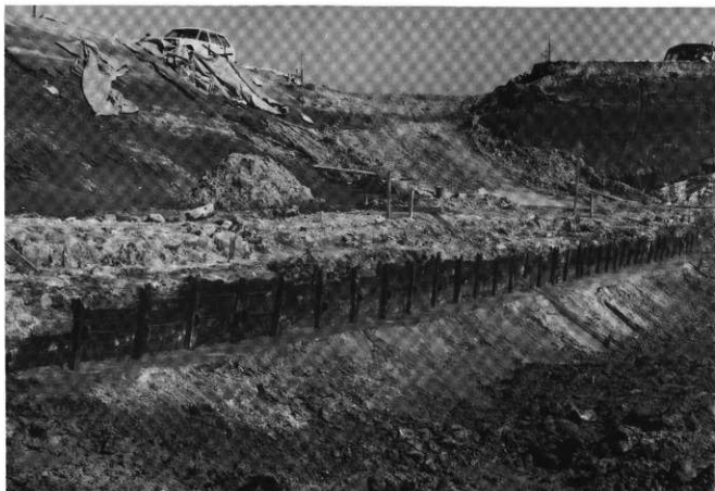
A区北侧区板棚
