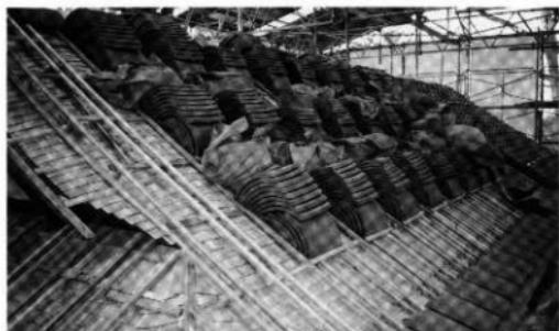
51. 六の平檜平瓦葺施工状態
