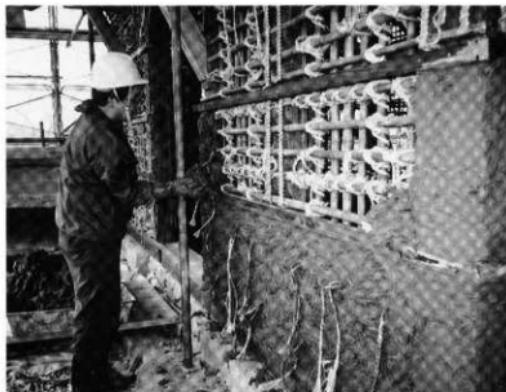
58. 五の平樋荒壁付け施工
