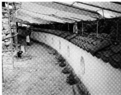
80. 土塀屋根瓦葺施工状態
