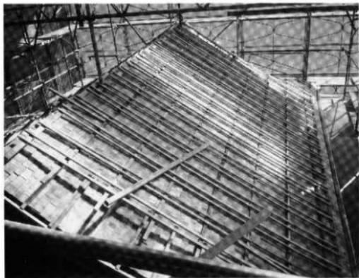
50. 五の平檜平瓦受用継棟打ち
