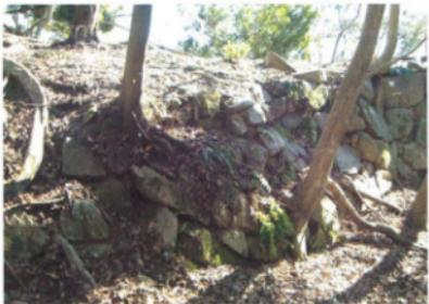
相畠城戸跡地区的土留石垣（ai21）は、土圧が最もかかる斜面先端部に当たる隅角を中心に崩壊している。
