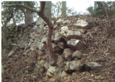
下太鼓の丸跡地区的上段南面石垣（st14）は、自然の岩盤との接続面のすき間ができ、岩盤周りの石垣が浮き出している。
