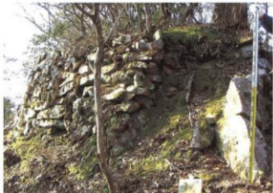
下太鼓の丸跡地区的上段南東面石垣のコーナー（st13・14）部は、下部の石材が大きくズレ出しており、崩壊の恐れがある。
