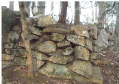
下太鼓の丸跡地区上段南東面石垣（st13）の隅角部は、右側石垣（st12）の崩壊部から連鎖的に崩れ出している。
