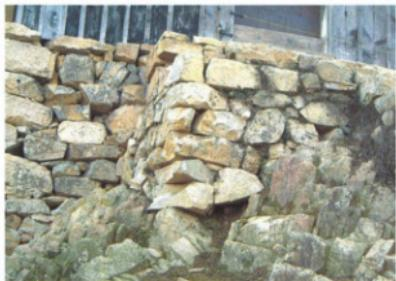
下太鼓の丸跡地区的北側雁木東面石垣（st5）の隅角部が大きく崩落している。北に接するst6も連鎖的な崩落の危険性がある。
