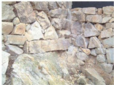
岩盤上に築いた天守台石垣。板状の石を据えている (km167)
