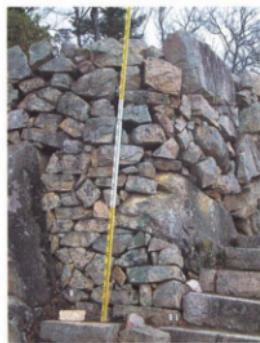
小松山城跡地区本丸下の段八の平橋西面石垣(km139)は、全体にハラミがみられるが、特に右隅角部の石材に割れが、スケ落ちがみられる。また、石垣高さも5mを越えるが、極めて急峻な斜面上に積まれており、地盤の安定性も絶対的なものではなく、崩落の危険性が高い。
