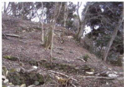
下太鼓の丸跡地区的南西端石垣（st40）は出角に小石材を混合して用いており、非常に不安定な積み方となっている。
