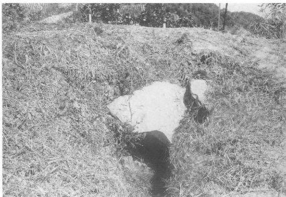
1号墳石室露出状況(横口部)
