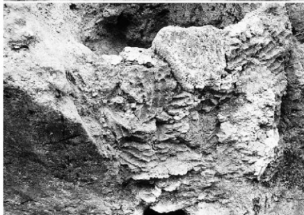
3 同上吸い込み口付近
