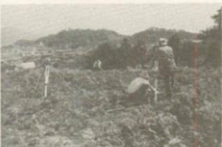
第6図 測量 (トラバースポイントの設定)
