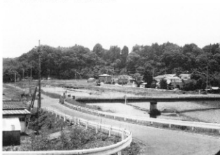
C 那賀城跡遠景 岩下橋より望む (北西より)
