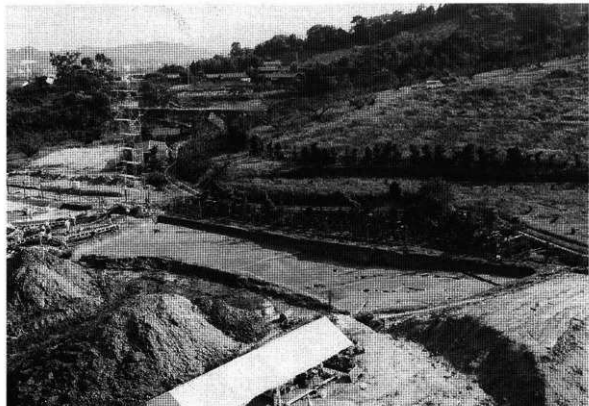
①-2区全景 北西より
