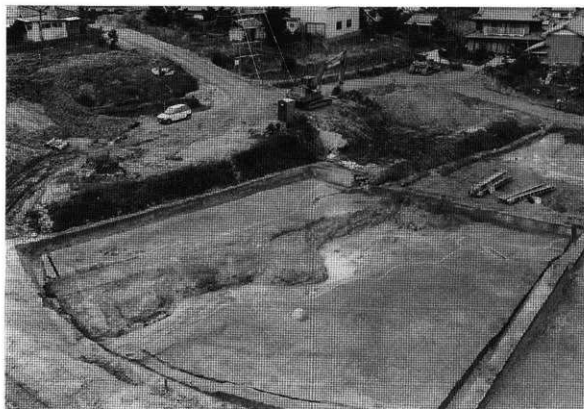
SR01 (5-1区) 完掘状況 南東より
