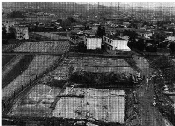
①-1区・②区全景 西より
