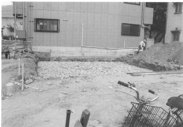
調査前全景（南から）
