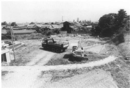
(1) 重機による表土除去作業
