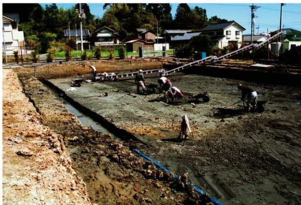
北区遺構検出状況
