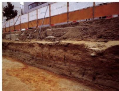
写真15 松杭基礎断面
