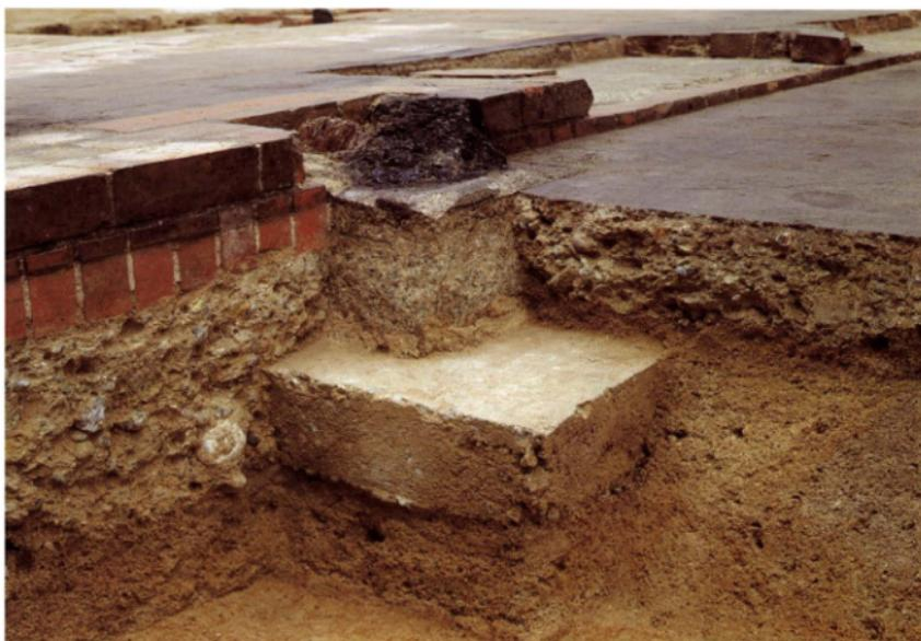
写真23 I期 南・北煉瓦積と土間の基礎断面
