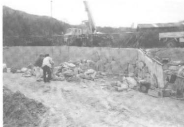
①コンクリート擁壁への石材張付作業風景
