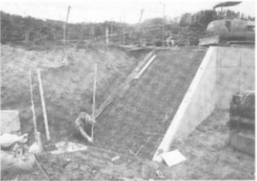
⑤コンクリート擁壁東側の階段工事
