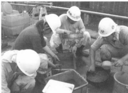
写真5 土壤水洗・選別作業風景
