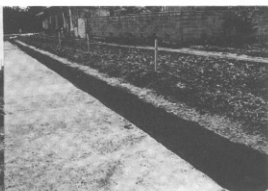
第3図 東西トレンチ南壁全景(西より)
