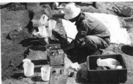
fig. III-1. 変性ウレタン系樹脂に7:3の割合で水を混ぜ、攪拌してから刷毛で塗る。
