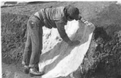
fig. III-7. 樹脂を塗り、硬化しないうちにガーゼを貼る
