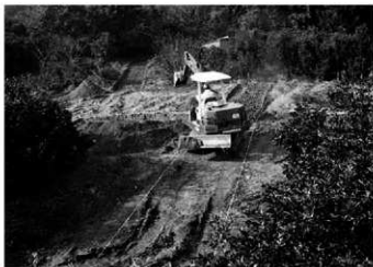
詰B区発掘調査風景
