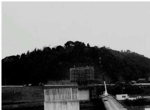
調査地遠景（東より）
