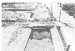
写真2 西水路④区全景
