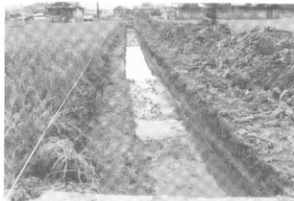
第2図 トレンチ掘削状況
