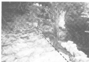
第2図 水口部～山手部石塁の折れ状況
