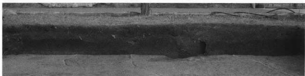
B-1 区東壁土層断面 (西より)
