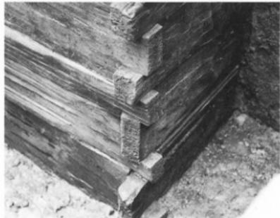
fig. 449 SE 201井籠組井戸枠細部
