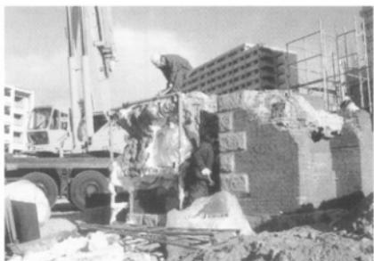
fig.13 煉瓦下水道跡切り取り
