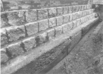
fig.56 第1橋台（西）前面根石積
