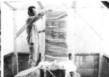
fig.254 接合後、石材強化剤を滴下
