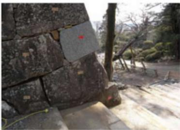
欠損している石材には、擬石処理を施す
