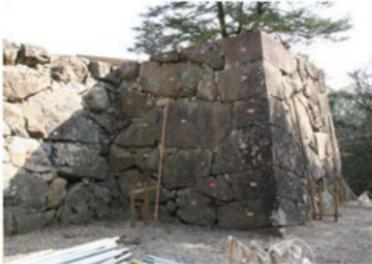
鉄門の積み上げが終了。破石以外の染石は元の位置に納まっている
