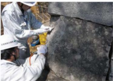
欠損している部分にエポキシ系樹脂と石材を粉末状
