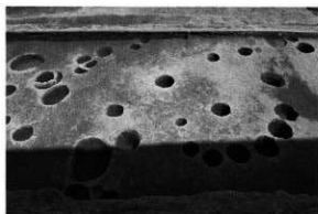
SB2完備状況 (西から)
