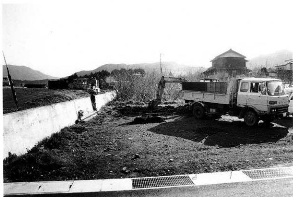
調査状況・表土除去（西より）
