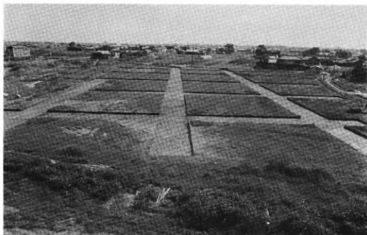
試掘トレンチ全景(北より)
