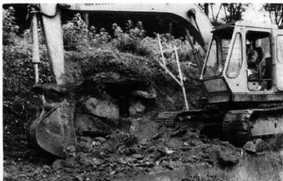
現道舗装除去
