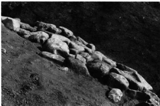
外護石積(上方より)
