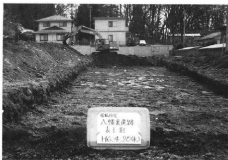
2 バックホーによる 表土剥ぎ(西から)
