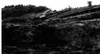
トレンチ掘削
