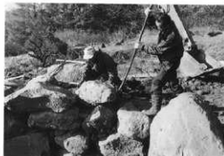
写30 側壁の補強工事 (平成9年)
