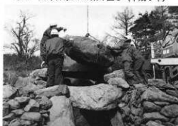
写32 天井石3tの架け直し
