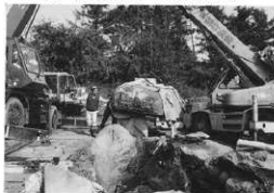
写28 天上石の除去 (平成9年)
