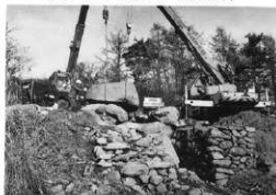
写31 天井石8.2tの架け直し (平成9年)
