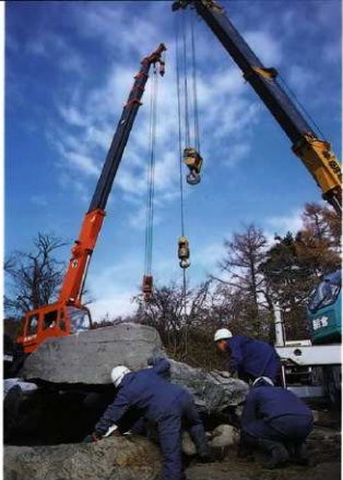
○ クレーン2台でやっと持ち上がった天井石、その重さ8.2トン
