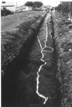
2. 西一本柳道跡A地区(東方より)
