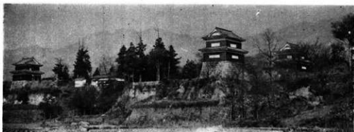
第10図 上田城跡本丸全景 向つて左が西櫓、右の手前が南櫓、そのうしろが北櫓である。
