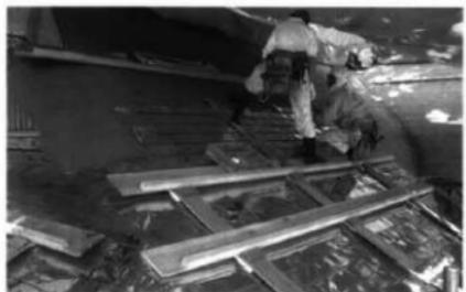
屋根10 上部の鋼板平葺き作業
