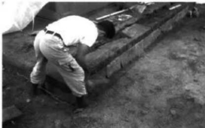
雑工2 西側基壇石積み据え直し作業
