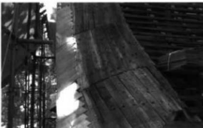
屋根10 水切り銅板・上目板の取り付け状況
