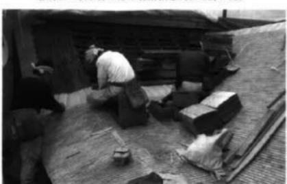
屋根14 正面平葺き葺き上げ作業
