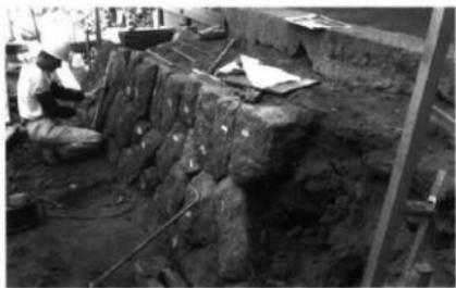
雑工8 東側基壇石積みの据え直し作業
