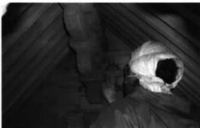
塗装2 棚組物の旧弁柄塗り搔き落とし作業
