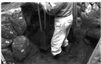
雑工7 東側基壇石積みの底部地固め作業
