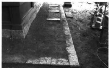
雑工5 基礎石積み補修完了
