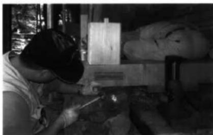
木工5 土台ひかり付け作業
