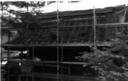
屋根8 旧葺材解体完了の状況
