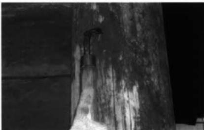
塗装1 柱の旧弁柄塗り搔き落とし作業
