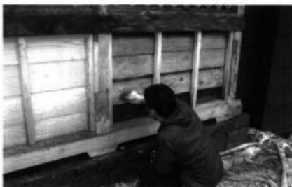
仮設8 透塀下見板壁の塗装作業
