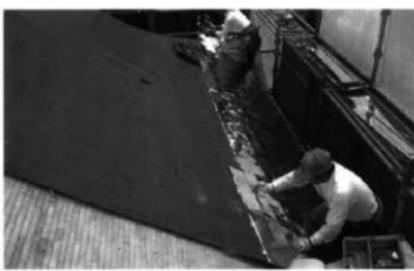
屋根8 銅板平葺き作業
