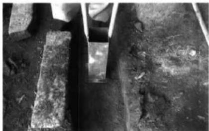
雑工2 基壇石積みの底部地固め作業
