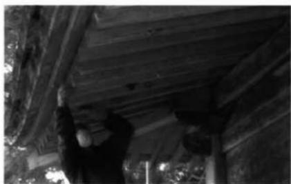
塗装1 軒の旧弁柄塗り搔き落とし作業
