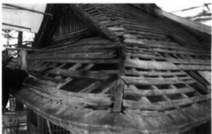
屋根3 鉄板葺き及び下地解体完了
