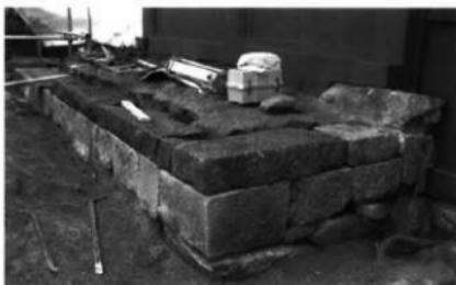
雑工3 西側基壇石積み据え直し完了
