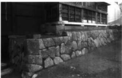
雑工9 東側基壇石積みの据え直し完了
