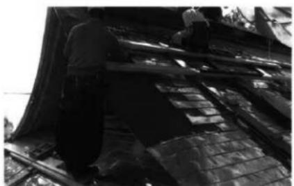
屋根11 裝甲部の鋼板平葺き作業
