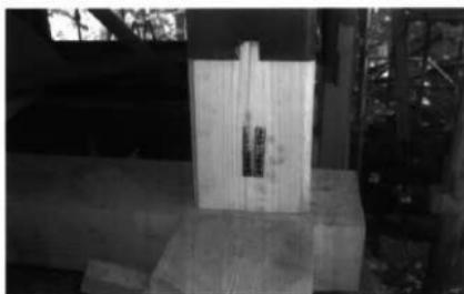
木工4 柱根離ぎ補修の状況
