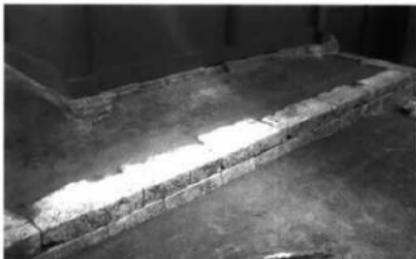
雑工4 西側基壇石積み上面整地完了
