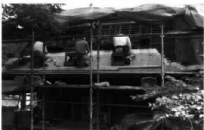
屋根12 脊面平葺き葺き上げ作業
