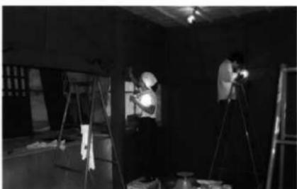
塗装5 内部弁柄塗り仕上げ作業
