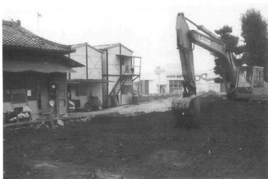
重機作業風景
