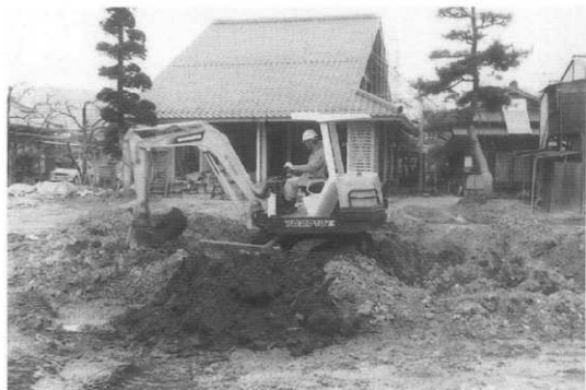
重機作業風景
