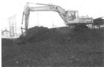
重機作業風景
