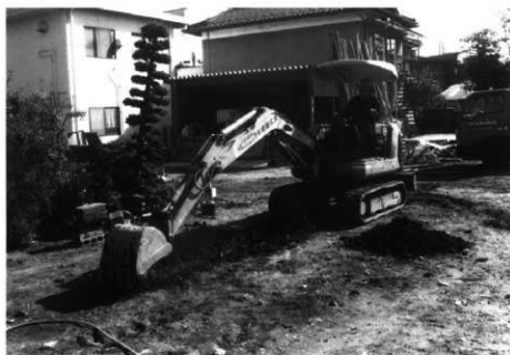
重機による掘削
