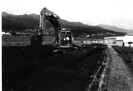
重機による掘削
