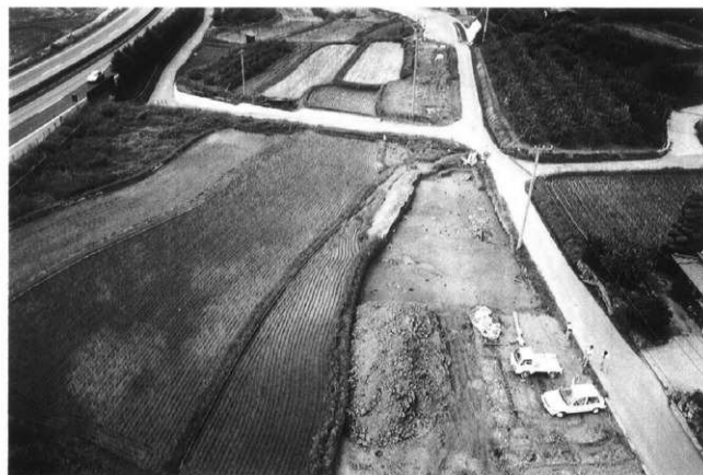
南側調査区全景（斜め上空北東から）
