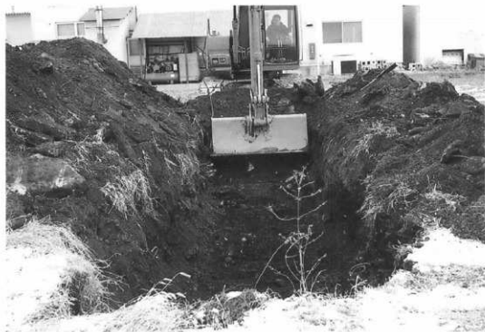
調査状況（南から）
