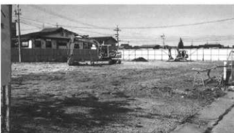
調査状況 (南から)
