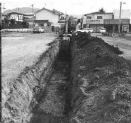
調査状況 (西から)
