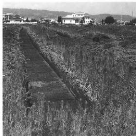
調査状況 (北から)
