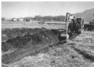
西赤座遺跡10トレンチ近景(南西から)
