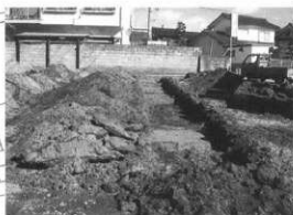
調査状況 (南から)
