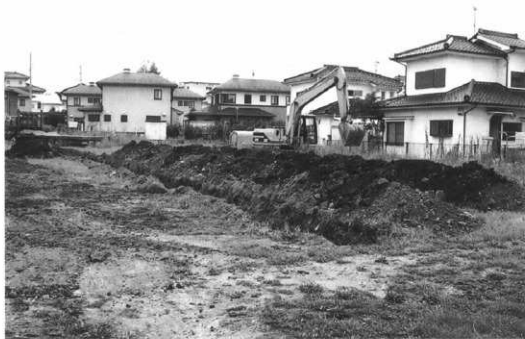
調査状況（北から）
