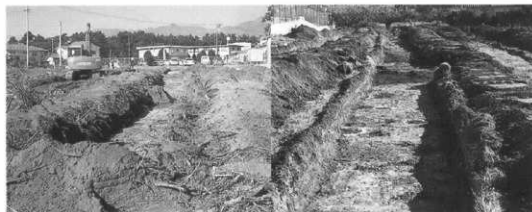
調査状況 (南から)
