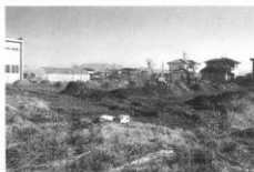
トレンチ掘削状況
