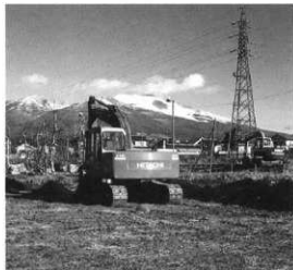
トレンチ掘削状況(南から)
