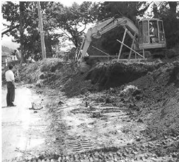
調査状況 (北から)
