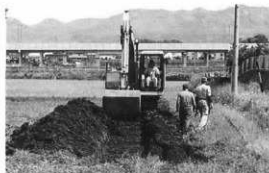
調査状況(南から)
