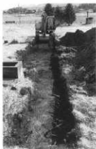
トレンチ掘削状況
