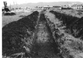
調査状況 (南から)
