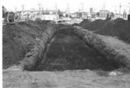
Eトレンチ (南から)
