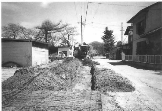
調査状況（西から）
