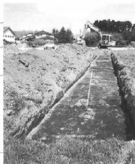
調査状況 (西から)
