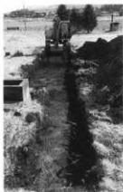
トレンチ掘削状況
