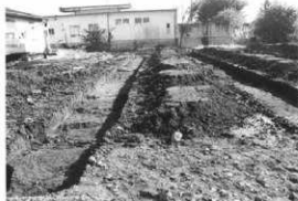
調査状況 (南から)
