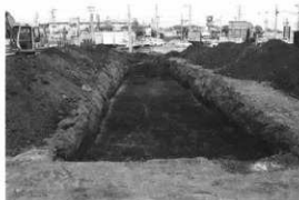
Eトレンチ (南から)
