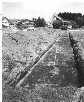
調査状況(西から)
