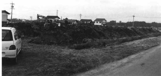
調査状況 (南から)
