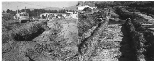
調査状況 (南から)
