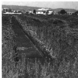
調査状況(北から)
