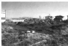
トレンチ掘削状況
