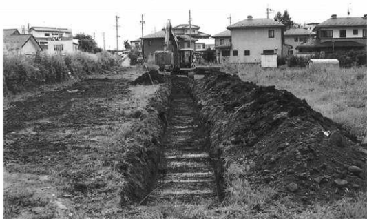
調査状況（北から）
