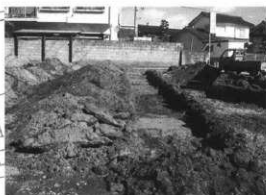
調査状況 (南から)
