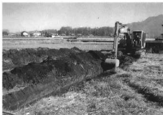
西赤座遺跡10トレンチ近景(南西から)
