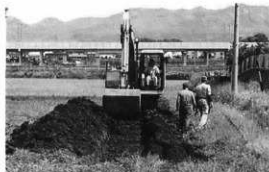
調査状況(南から)
