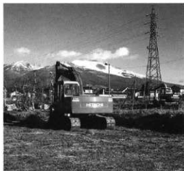
トレンチ掘削状況 (南から)
