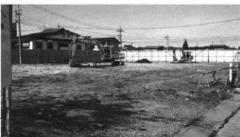
調査状況 (南から)
