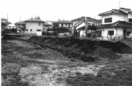
調査状況（北から）
