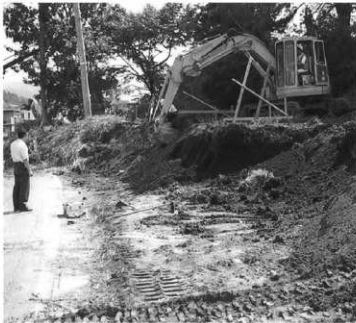
調査状況 (北から)
