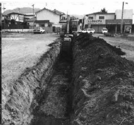
調査状況 (西から)
