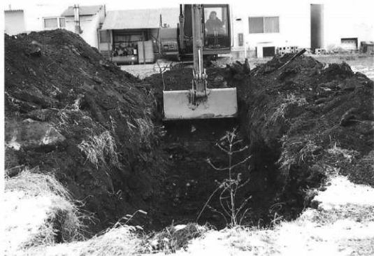
調査状況（南から）
