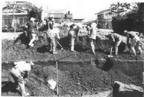
埋め戻し作業
