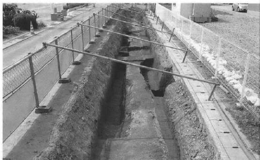
城ノ内遺跡調査区西半部 (北側より)
