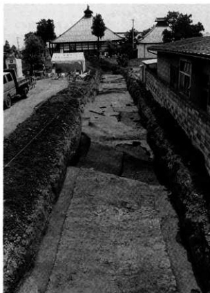
写真21 調査区全景（西から）
