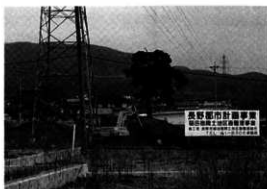
写真3 4月18日重機掘削
